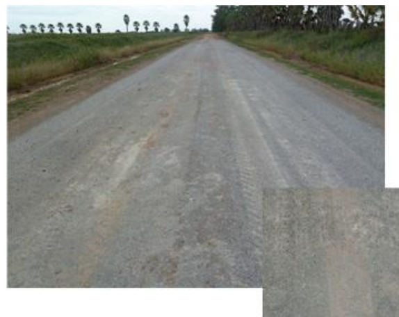
Riego asfáltico de curado - sellado
