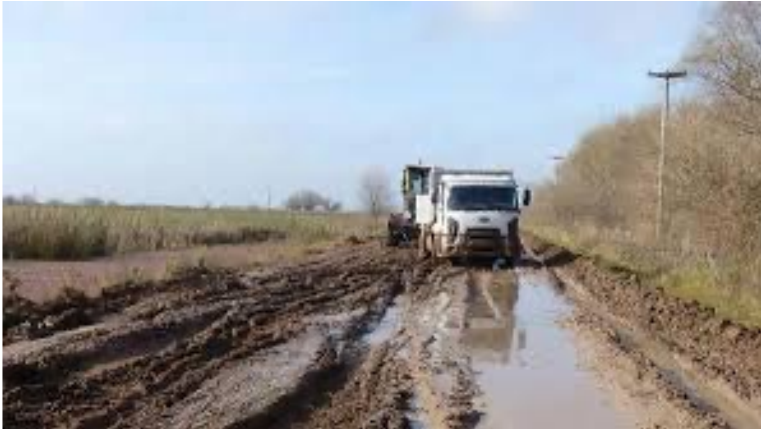
Foto 1: estado típico de un camino rural en períodos de lluvias intensas. El ahuellamiento provocado por el paso de los vehículos cuando el terreno está barroso, no sólo resulta poco confiable sino que, además, deteriora el nivel de servicio del camino a niveles intolerables.
