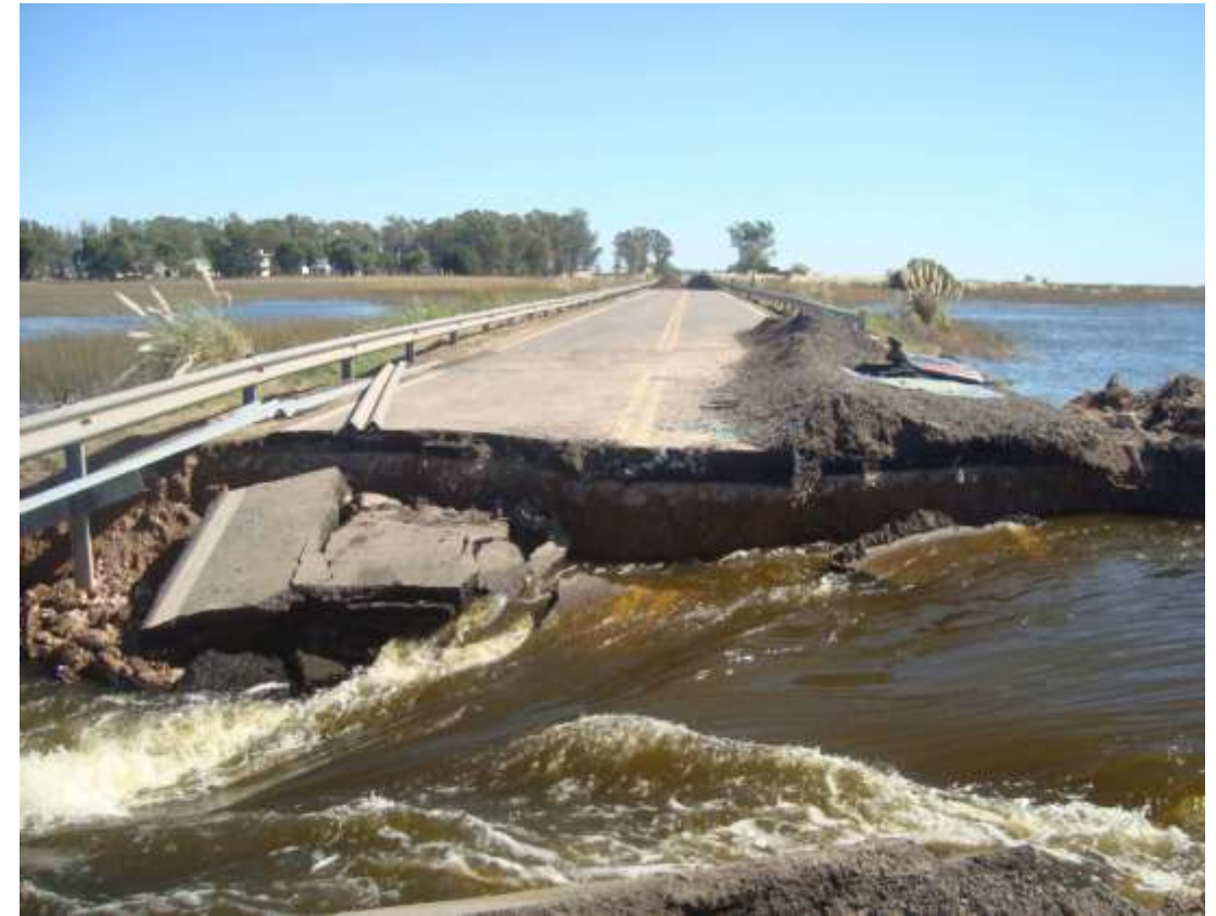
Falla del terraplén y paquete estructural
