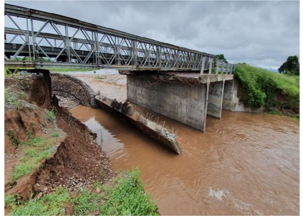
Erosión en pie de alcantarillas – Falla estructural
