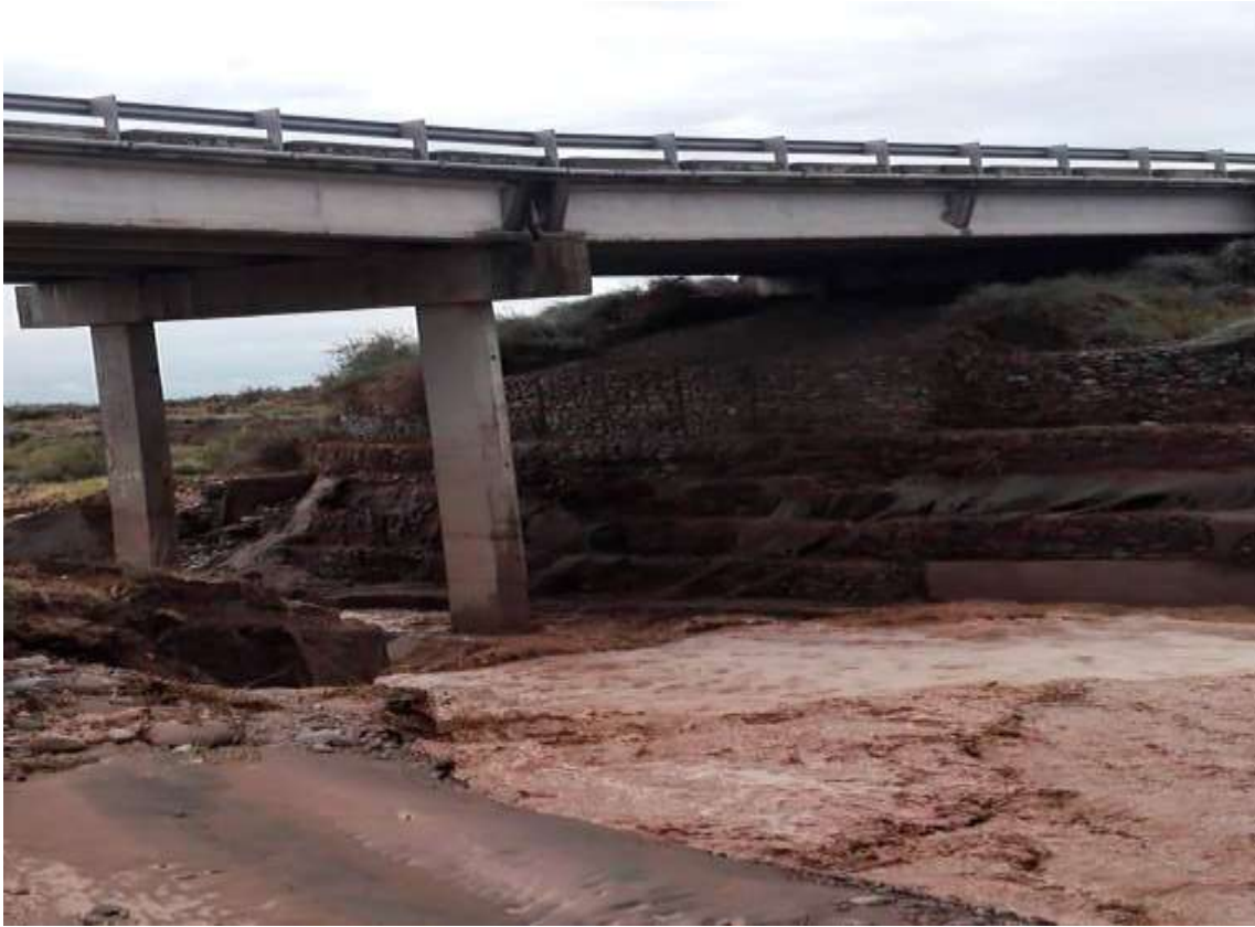
Erosión en pilas (extracción áridos)
