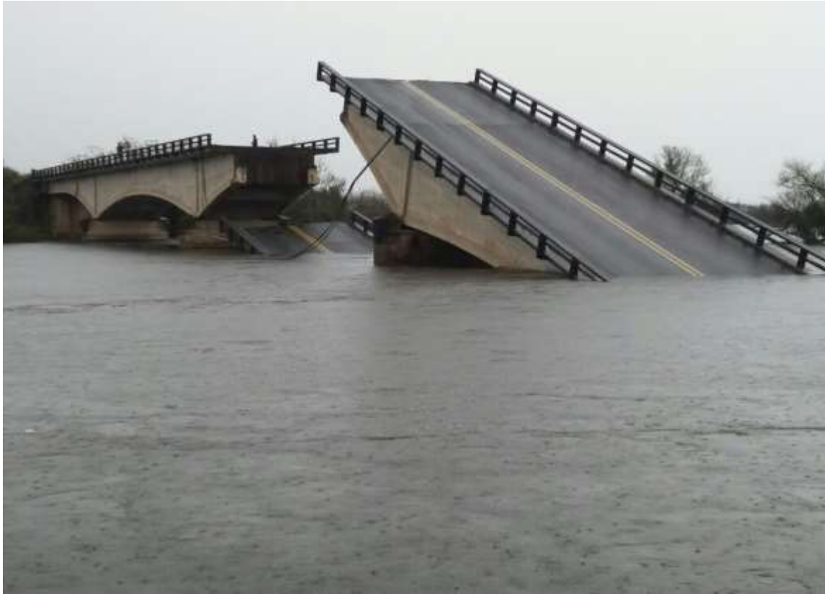
Colapso estructural por erosión en pilas
