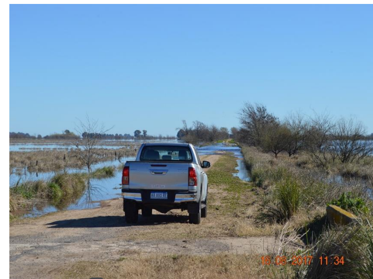
Falta alcantarilla y alteo
